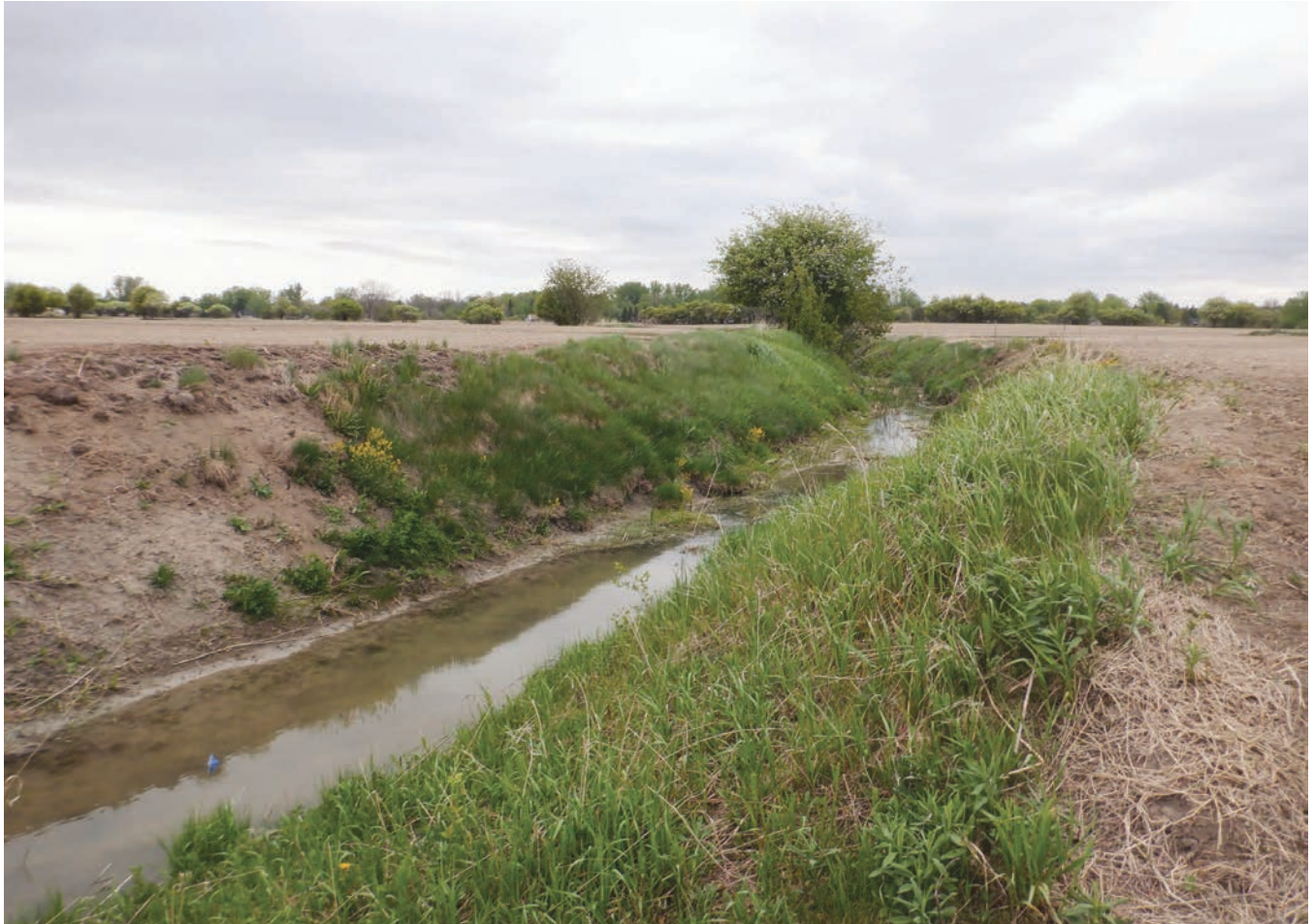
Fossé nécessitant des soins de restauration : revégétalisation du talus et installation d'une bande riveraine.
